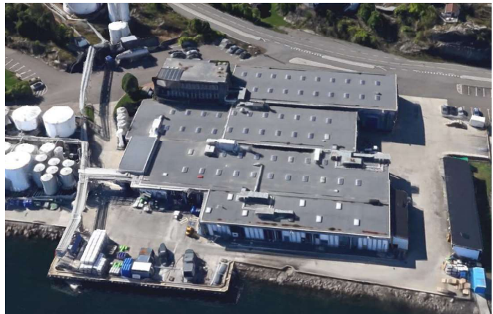
Figur 3: Oversiktsbildet viser bygg med administrasjon og produksjonshall nord (kilde: www.google.com/earth )
