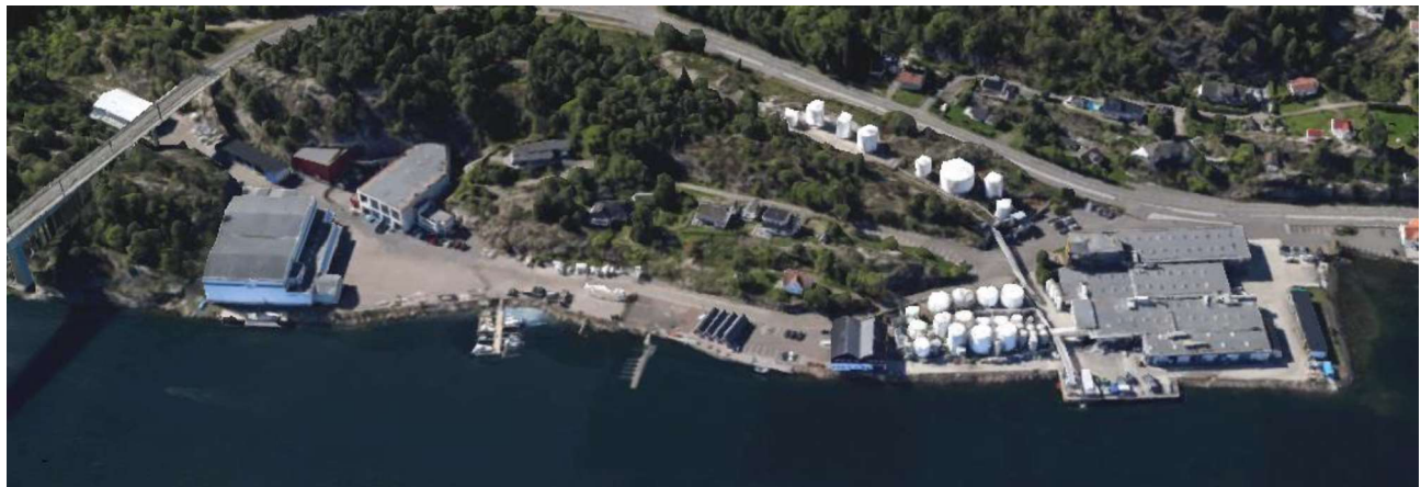
Figur 1: Oversiktsbildet viser produksjonsanlegget
